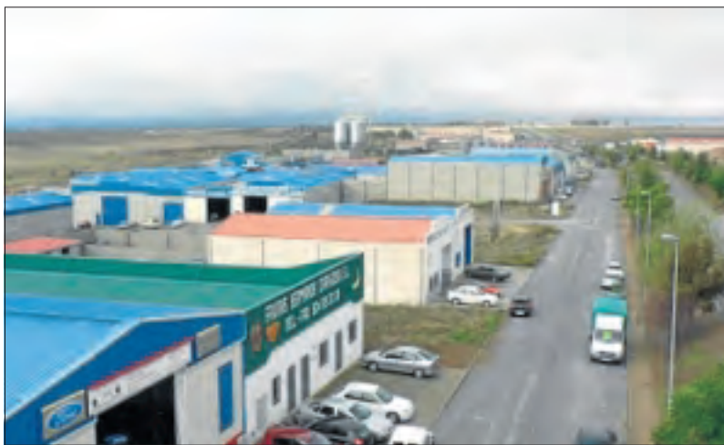
Panorámica de un polígono industrial en La Campiña Sur.
